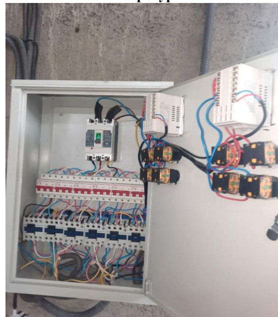
Рис. 6. Щит-автомат для регулирования температуры жидкости в реакторе
