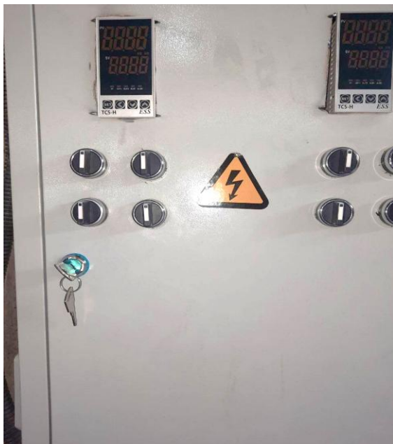
Рис. 6. Щит-автомат для регулирования температуры жидкости в реакторе
